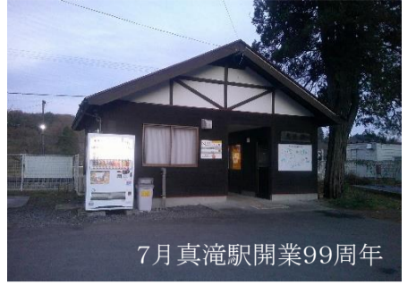
7月真滝駅開業99周年 真滝駅は真滝村に由来した名称で大正14年7月26日開業 現駅舎は平成10年改築
